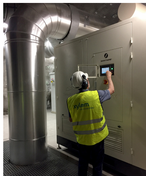
Driftsättning av blåsmaskin MAX 600 (400 kW).
